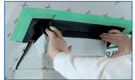
Innenecken mit Putzträger
