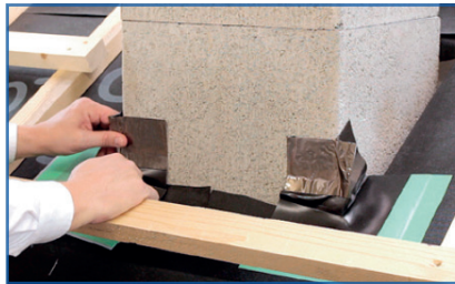
Innenecken ohne Putzträger
